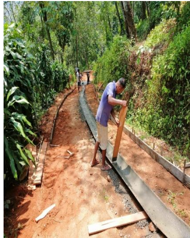
Weg in aanleg
